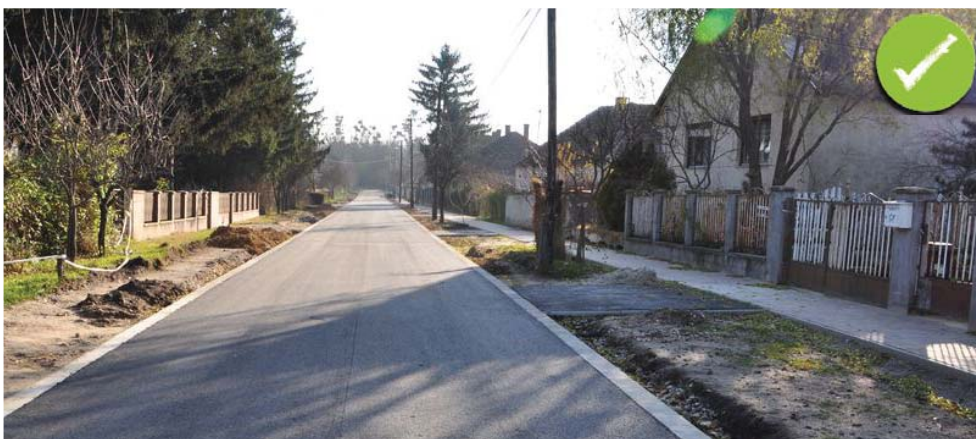
[59] ÉPÍTETT ÚTSZEGÉLY, RENDEZETT, ASZFALTOZOTT BEJÁRÓKKAL KISBÉREN Fotó: gombosfoldgep.hu
