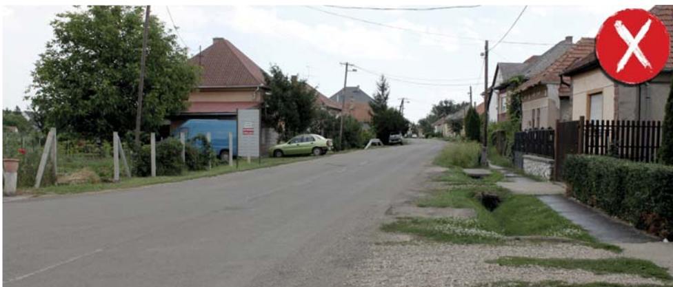
[58] SZÉTFAGYOTT, LEJÁRT PADKA, RENDEZETLEN BEJÁRÓKKAL Fotó: Tunnel Kft.
