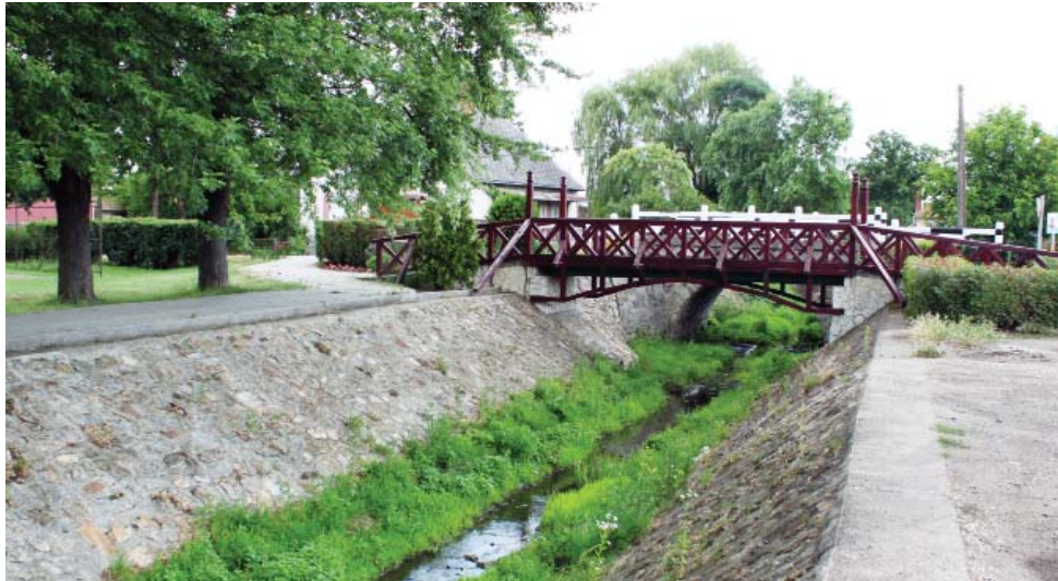
[46] FA SZERKEZETŰ GYALOGHÍD Tunnel Kft.
