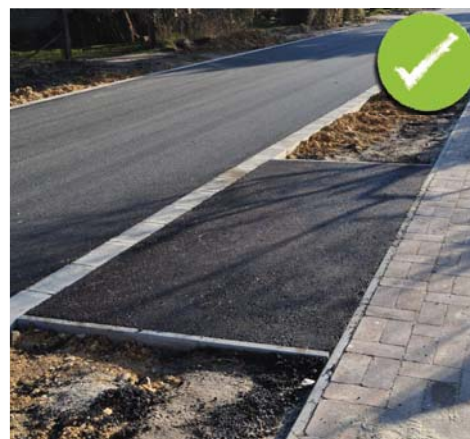
[61] SZEGÉLYEKSEL KIALAKÍTOTT, ASZFALT BEJÁRÓ AZ ÚTTEST ÉS A JÁRDA KÖZÖTT Fotó: gombosfoldgep.hu
