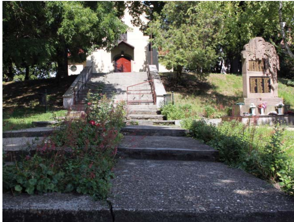
[35] A TEMPLOM LÉPCSŐJE Tunnel Kft.
