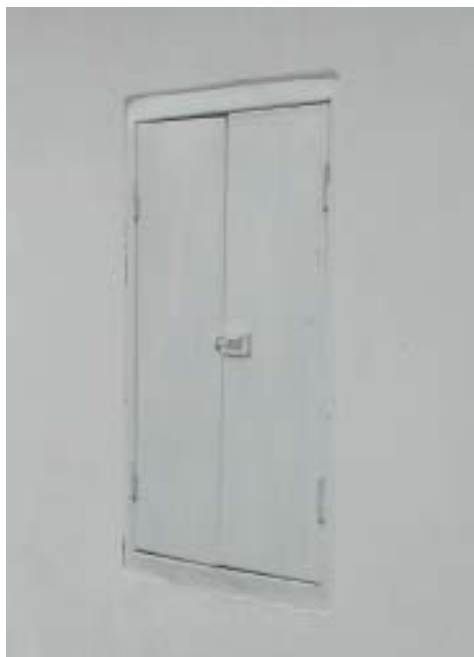
[3] HOMLOKZATBA INTEGRÁLT KÖZMŰÓRA fotó: Grafit Műterem Kft.
