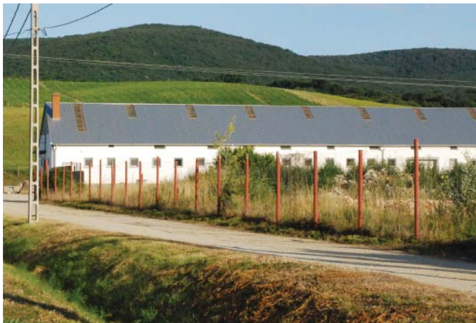
[26] GAZDASÁGI ÉPÜLET FELSŐTÁRKÁNY TERÜLETÉN vakolt homlokzatrészlet fotó: Grafit Műterem Kft.
