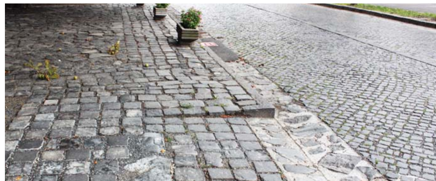
[57] HELYI BAZALT TERMÉSKŐ ALKALMAZÁSA BADACSONYTÖRDEMIC KÖZPONTJÁBAN: FORGALOMCSILLAPÍTOTT ÚTPÁLYA: KISKOCKA (JOBBRA) JÁRDA: FELEZETT NAGYKOCKA (KÖZÉPEN) ÉS SZABÁLYTALAN KŐ BAZALTZÚZALÉK HÉZAGOLÁSSAL (BALRA FENT) PUFFER TERÜLET: BAZALT ZÚZALÉK (BALRA LENT) KERÜLENDŐ PÉLDA: BETONBA RAKOTT SZABÁLYTALAN TERMÉSKŐ NAGY FUGÁKKAL Fotó: Tunnel Kft.
